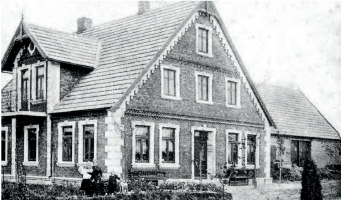
Das so genannte „Müller-Haus“, 1903 von Windmühlenbetreiber Hermann Albers in der Nähe seiner Mühle erbaut, ist weitgehend originalgetreu erhalten geblieben.
