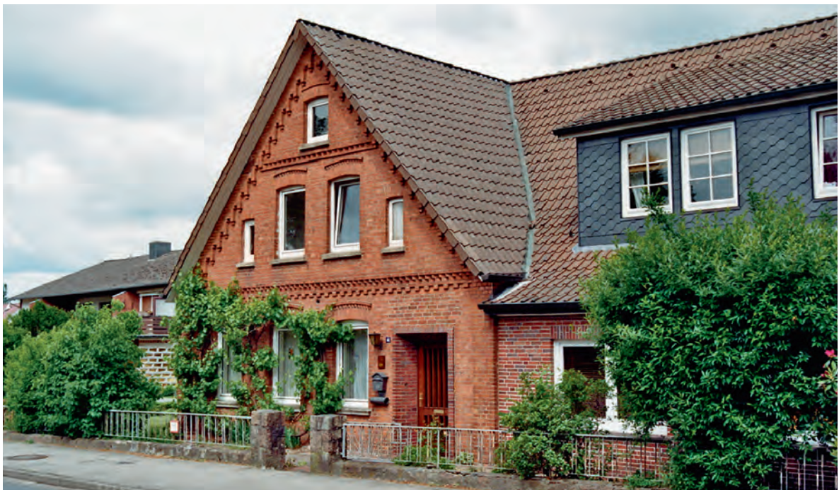
Das im Jahre 1900 erstellte Wohngebäude wurde an das Altgebäude angebaut.
