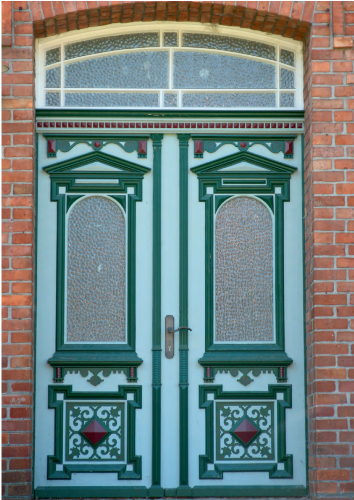
Haustür von der Nordseite aus gesehen.
