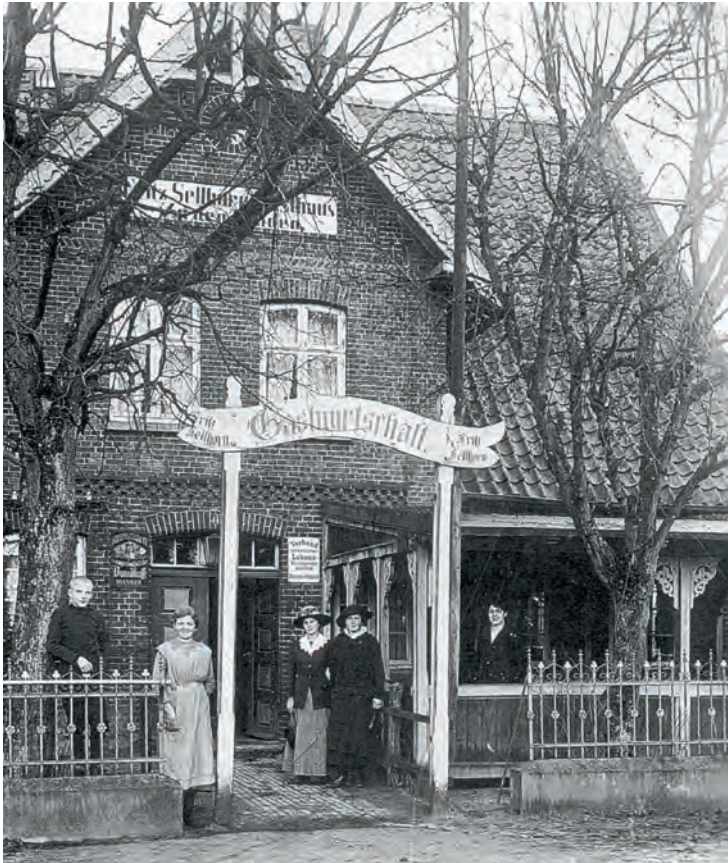
Diese Aufnahme zeigt die Gaststätte „Sellohorn“ nach dem Umbau zur Gastwirtschaft „Zu den Linden“ (Aufnahme etwa 1910).
