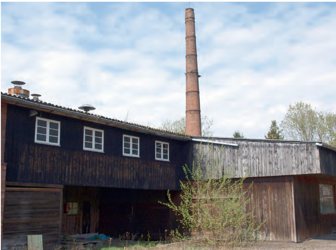
Rechts neben dem Wohngebäude befindet sich derzeit noch das stillgelegte Sägewerk der Familie Heuer mit dem emporragenden Schornstein. Auf dem Gelände soll in naher Zukunft eine Einzelhandelsfläche entstehen.
