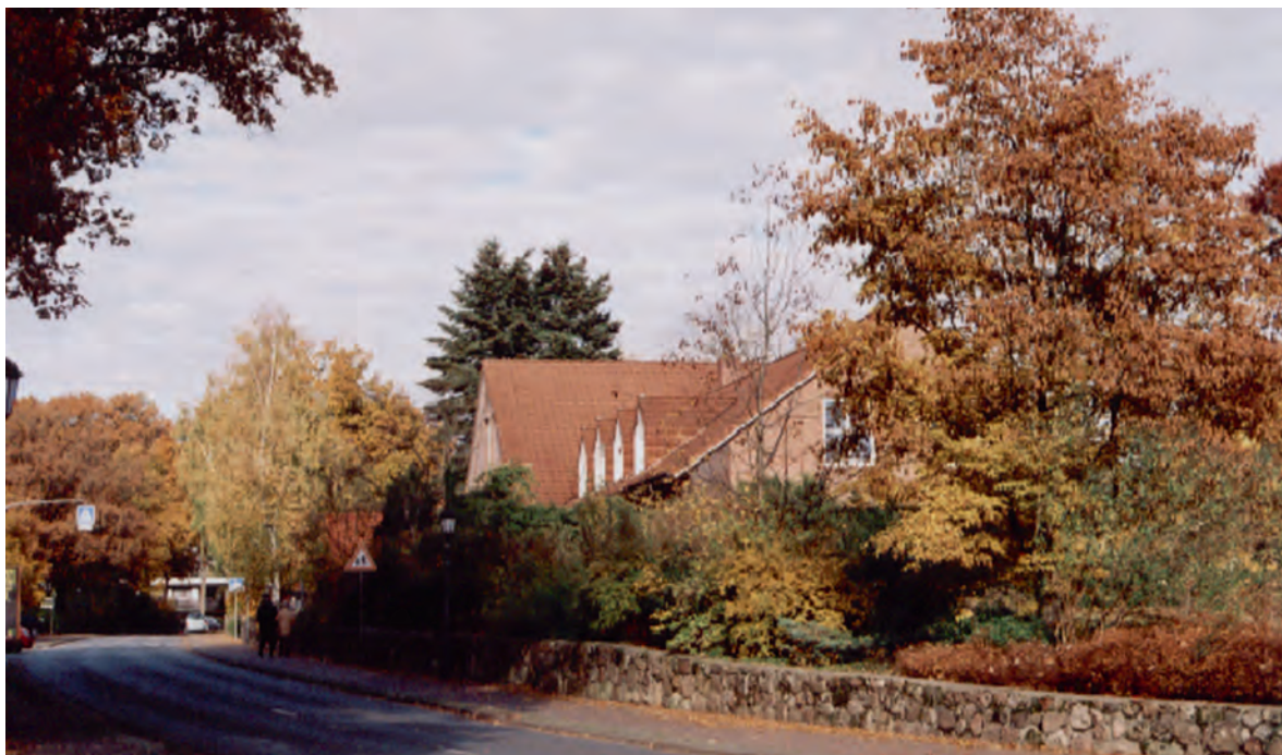
Auf demselben Grundstück steht das neue Pfarrhaus (Zustand nach dem Umbau 1994). Es dient als Gemeindehaus, hat eine Wohnung für den Pastor und beinhaltet das Pfarrbüro.
