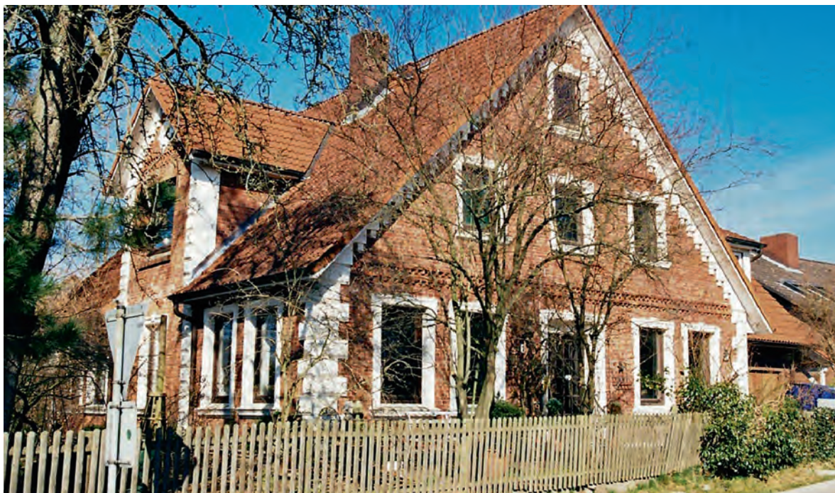
Heutige Ansicht des Gebäudes.
